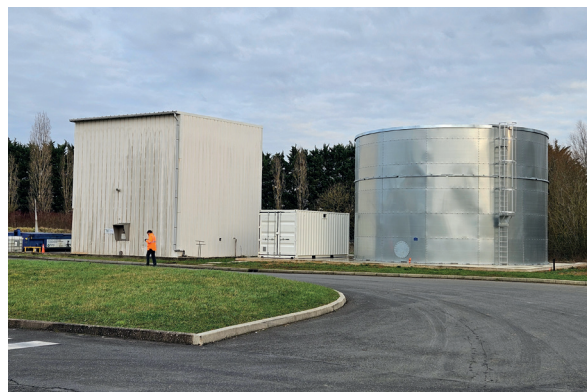
La nouvelle cuve de récupération des eaux pluviales, d'une contenance de 500 m 3 permet d'économiser 6000 m 3 d'eau par an.
