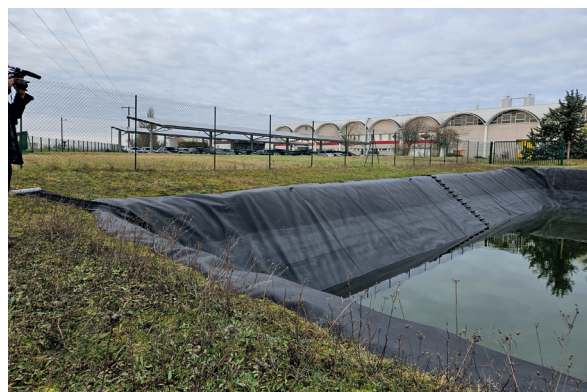
Le bassin de rétention des eaux pluviales équipé de rampes d'évacuation pour les grenouilles.
